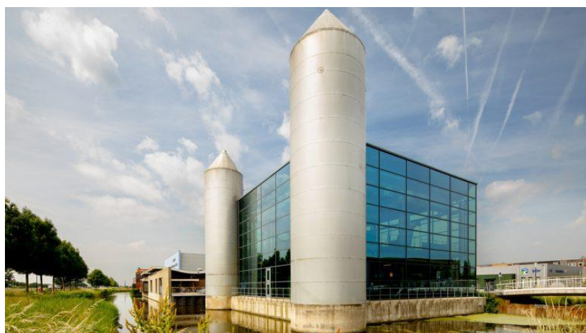
Afbeelding 2.16 Warmteoverdrachtstation (boven) en onderstation (onder)
