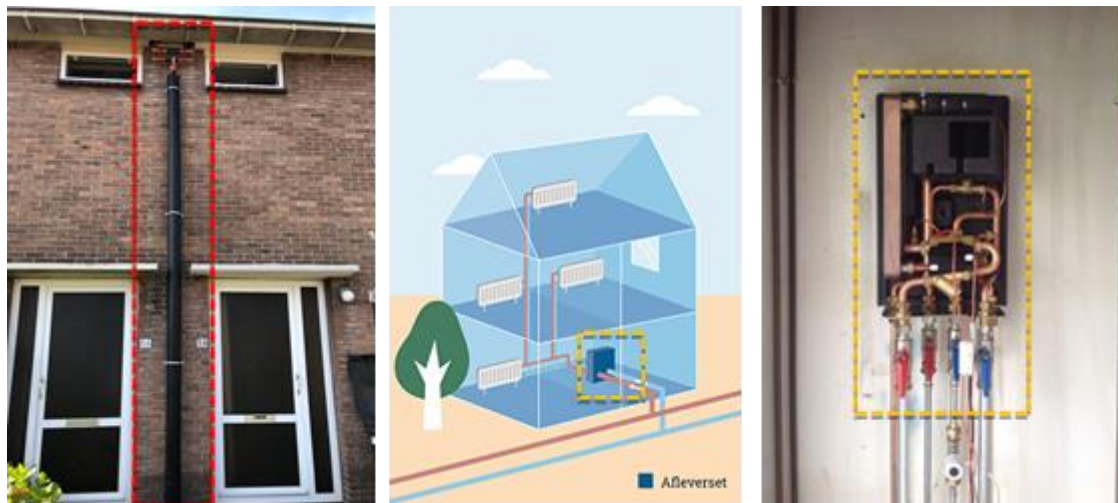
Afbeelding I.8 Aansluitleiding langs de gevel en afleverset
